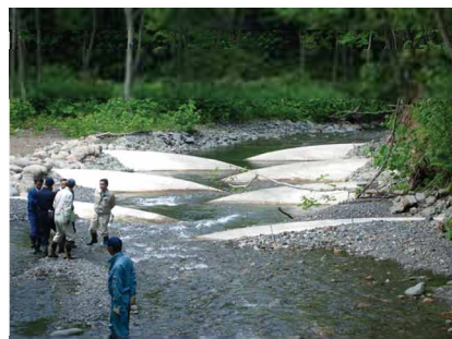
写真一 5 調節効果を発揮する摩擦型ダム
