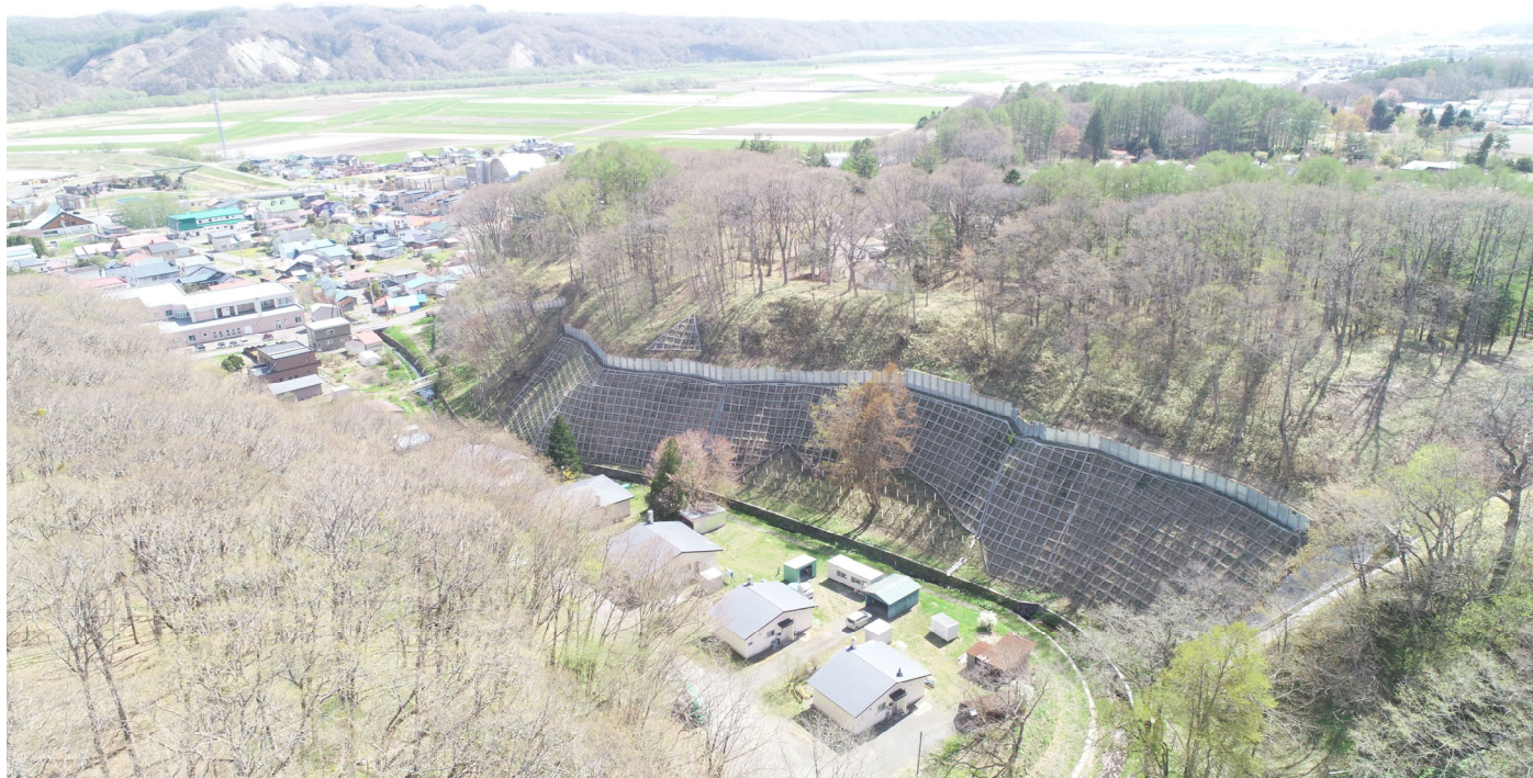
令和3年度 治山写真コンクール金賞作品：人命を守る治山施設 (撮影場所：平取町)
